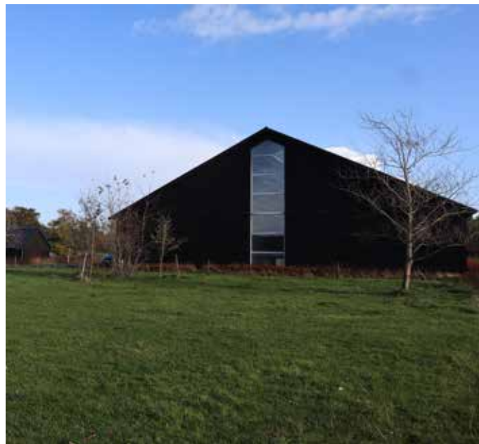
Færch Fonden, som ejer Kaas Hovedgård, byggede ny kvægstald for nyligt. De primære materialer er træ – både for klimaets skyld, men også for at stalden arkitektonisk falder ind i omgivelserne.
