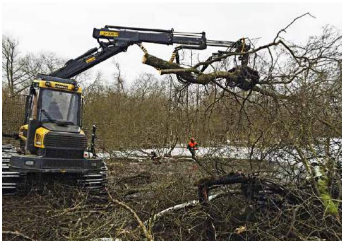
HedeDanmark udfører de rekreative og naturforbedrende tiltag i Ejby Mose ved Middelfart.
