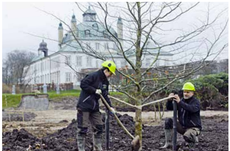
Anlæggelse af fire nye haver ved Fredensborg Slot
