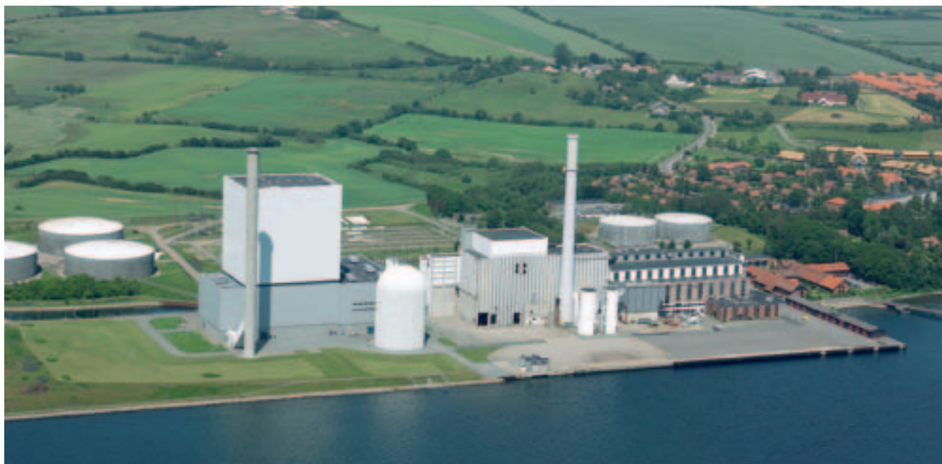
Skærbækværket skal ombygges, så det i fremtiden kan levere grøn varme til 200.000 østfyder i Trekantområdet.
