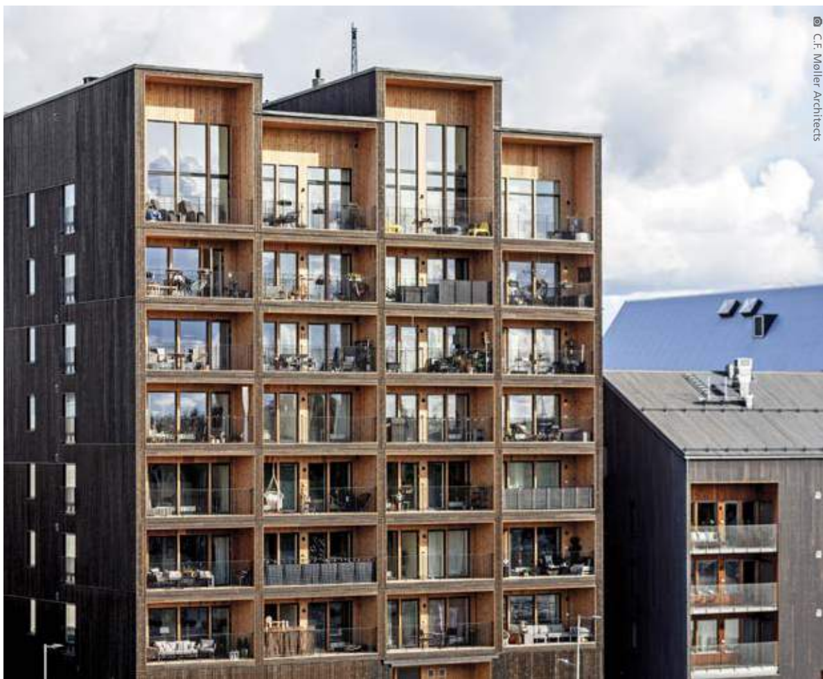
C.F. Møllers største træbyggeri Kajstaden i Västerås i Sverige. Den høje bygning er 2400 m 2 , og hele komplekset er 7500 m 2 .
