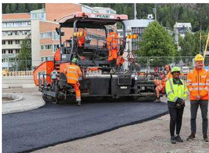
Den svenske entreprenørkoncern Peab anlagde i juli en prøvestrækning bioasfalt på en trafikeret vej i Sundsvall.
