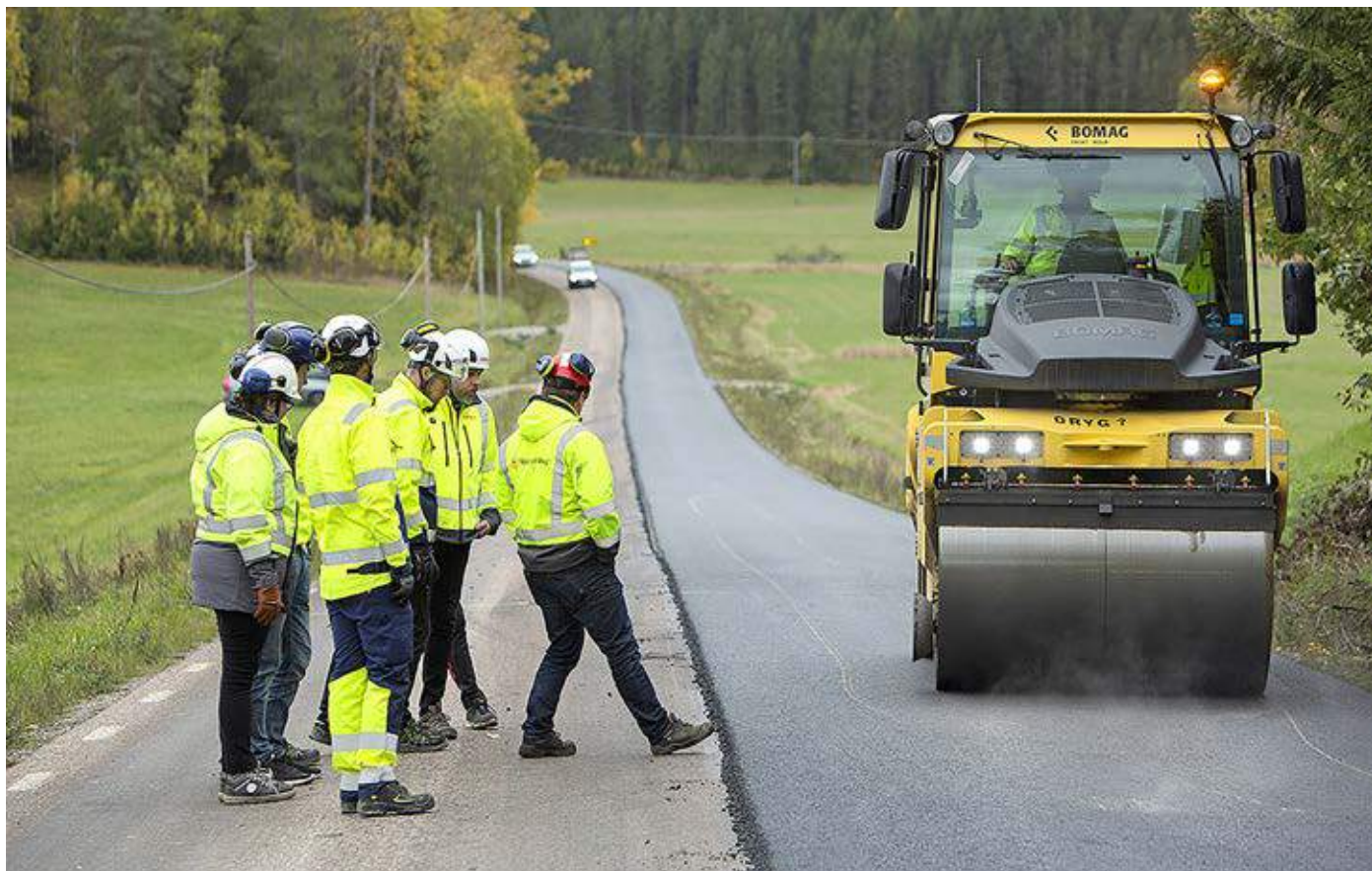
I Sverige er der i 2020 udlagt asfalt på to forsøgsstrækninger hvor halvdelen af bitumen i asfalt er erstattet med lignin der udvindes af træ. Her forsøget udført af Svevia.
