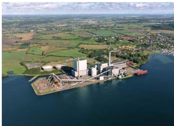
Et af de undersøgte værker er Skærbækværket ved Kolding som er omlagt til træfyring.
