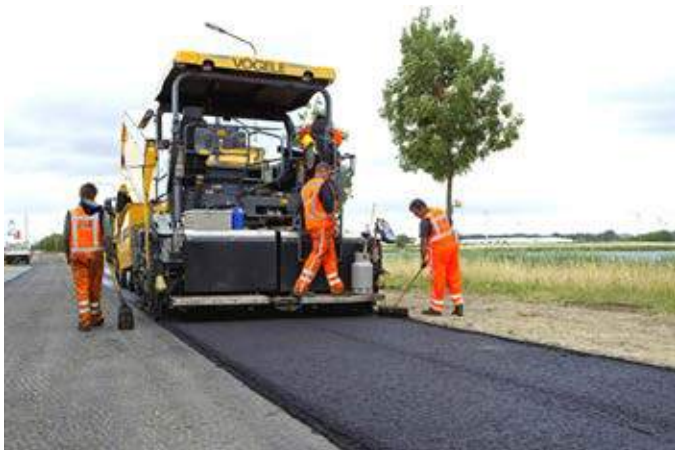
Holland er førende med udvikling af asfalt med lignin. Siden 2015 er der der udlagt 7 km bioasfalt på 11 vejstrækninger.
