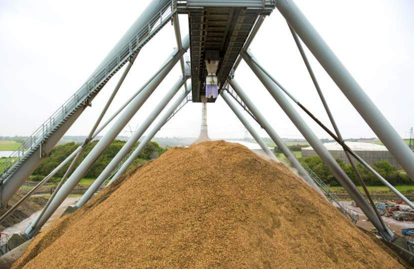
Flislageret på Skærbækværket.
