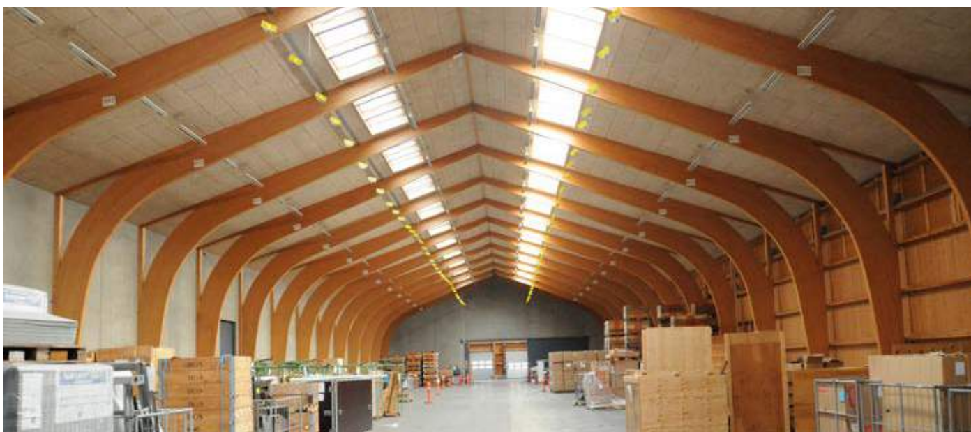
De bærende konstruktioner er traditionelle limtræsuer og gitterspær.
