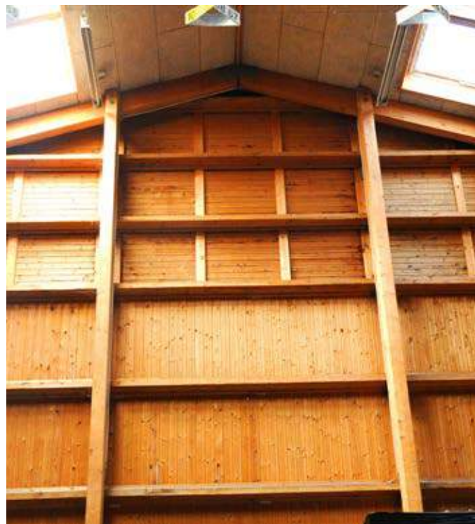
Alt træ bliver gråt i løbet af et par år når det udsættes for sollys. Men indvendigt i hallen kan man se hvordan den oprindelige farve var på træet.
