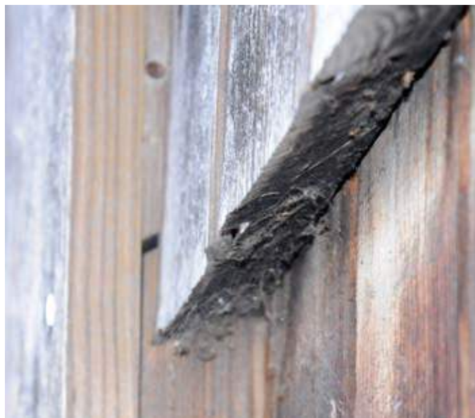
De lodrette brædder er skråt afskåret med en vandnæse, så regnvand kan dryppe af.
