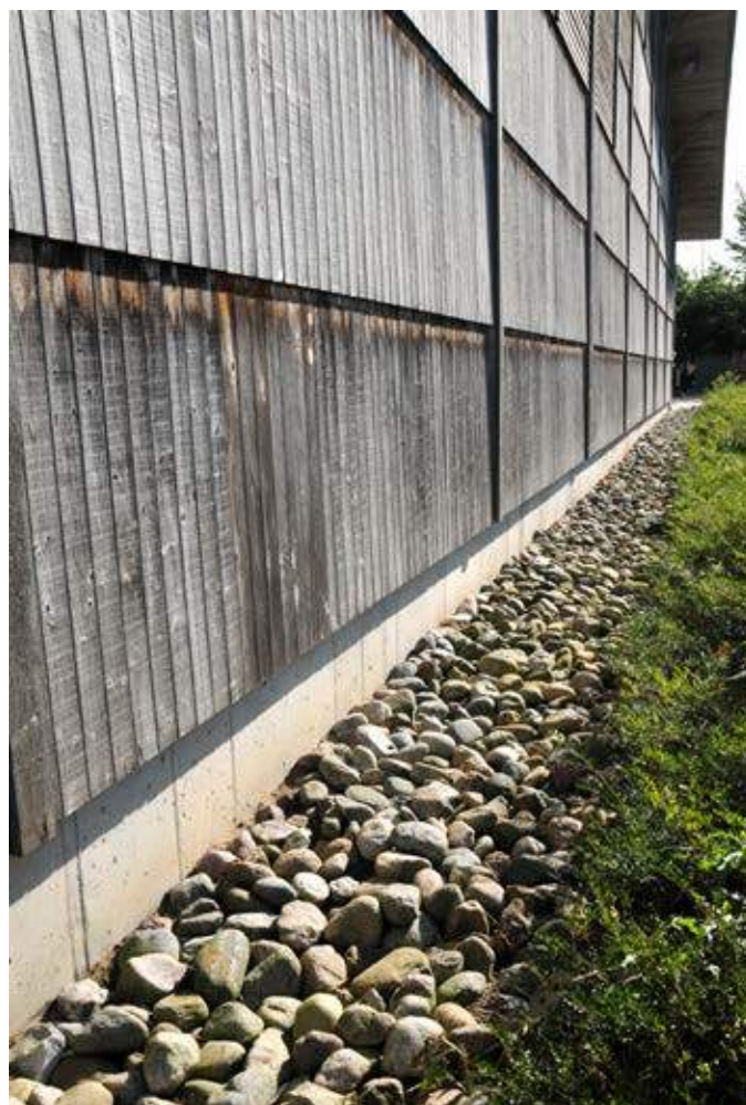
En høj sokkel og store sten langs soklen forhindrer at regnvand sprøjter op på facaden.
