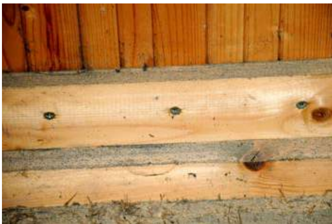
Søm og skruer er monteret indefra for at undgå huller i facaden.
