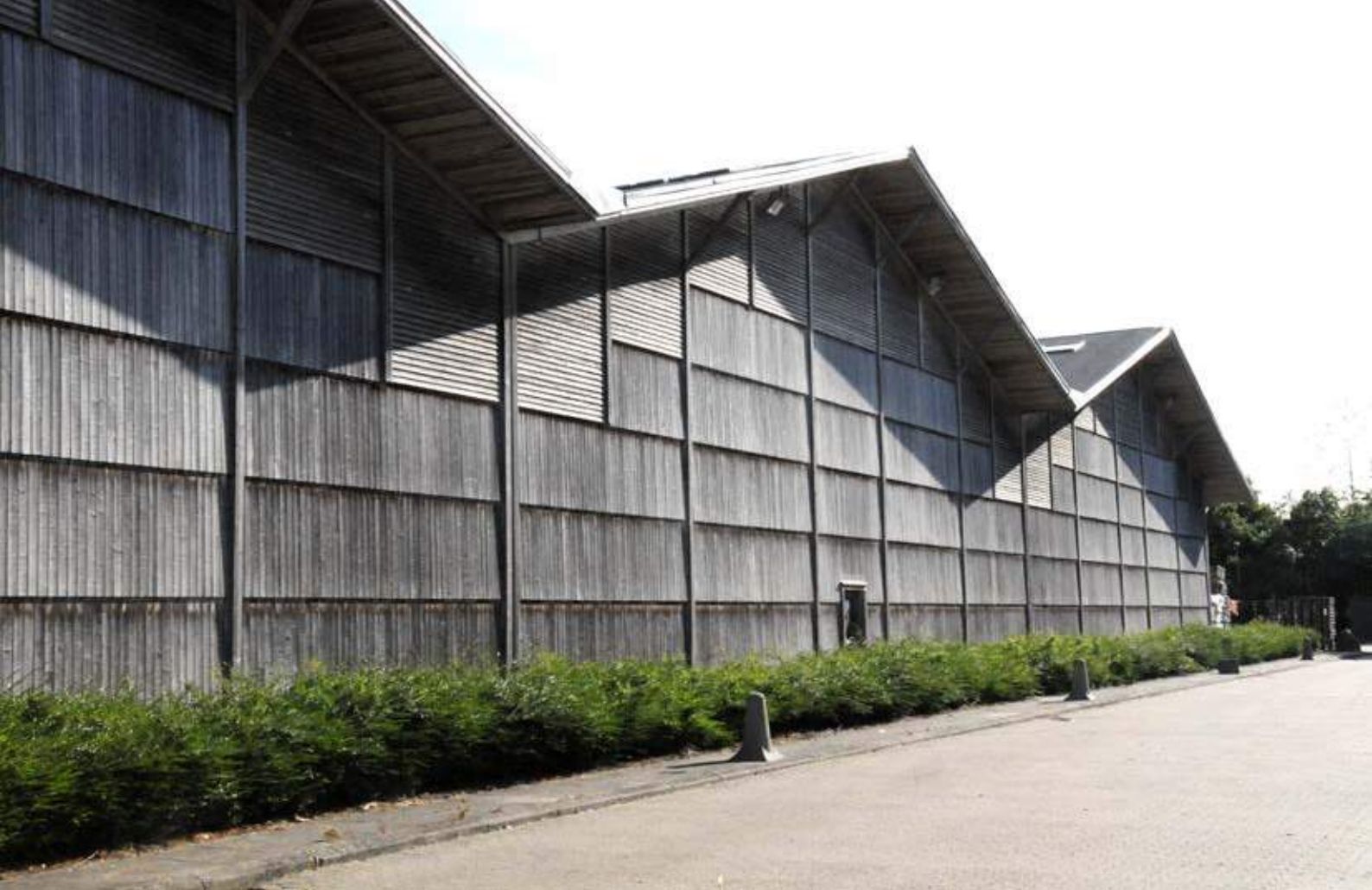
Gavlen mod vest er blevet eksponeret for vind og sol. Den er velbevaret og har fået en flot, ensartet farve.
