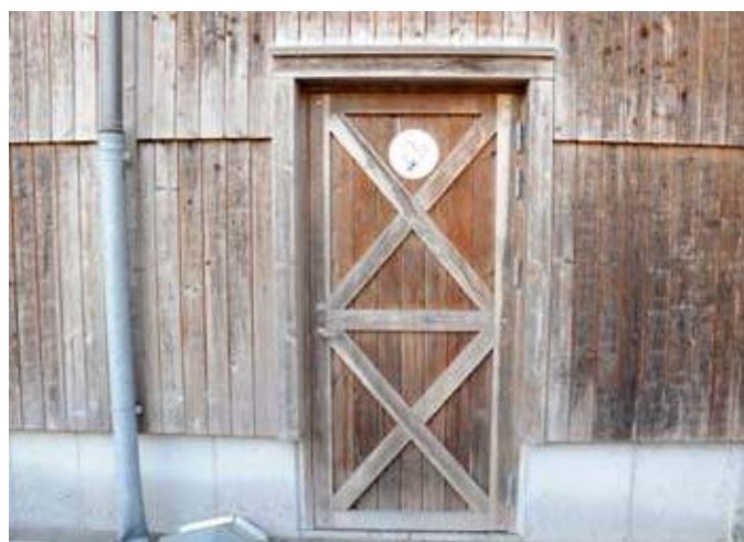
Der er anvendt brædder af douglasgran til døren og facaden ved siden af døren – de holder farven lidt bedre. Over dørkarmen bemærkes desuden et bræt som leder vand væk.
