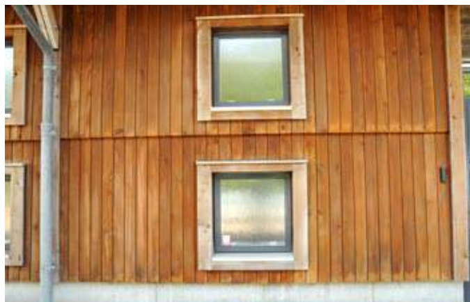
En sidebygning er opført med brandimprægneret skovfyr og har bevaret en smuk varm farve.
