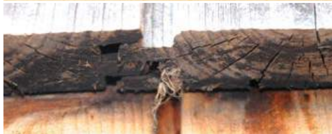
Nærbillede af modul med lodret beklædning. Marvsiden vender udad, og brædderne er samlet med en dobbelt fer-not samling hvor der er en lille afstand mellem brædderne.
