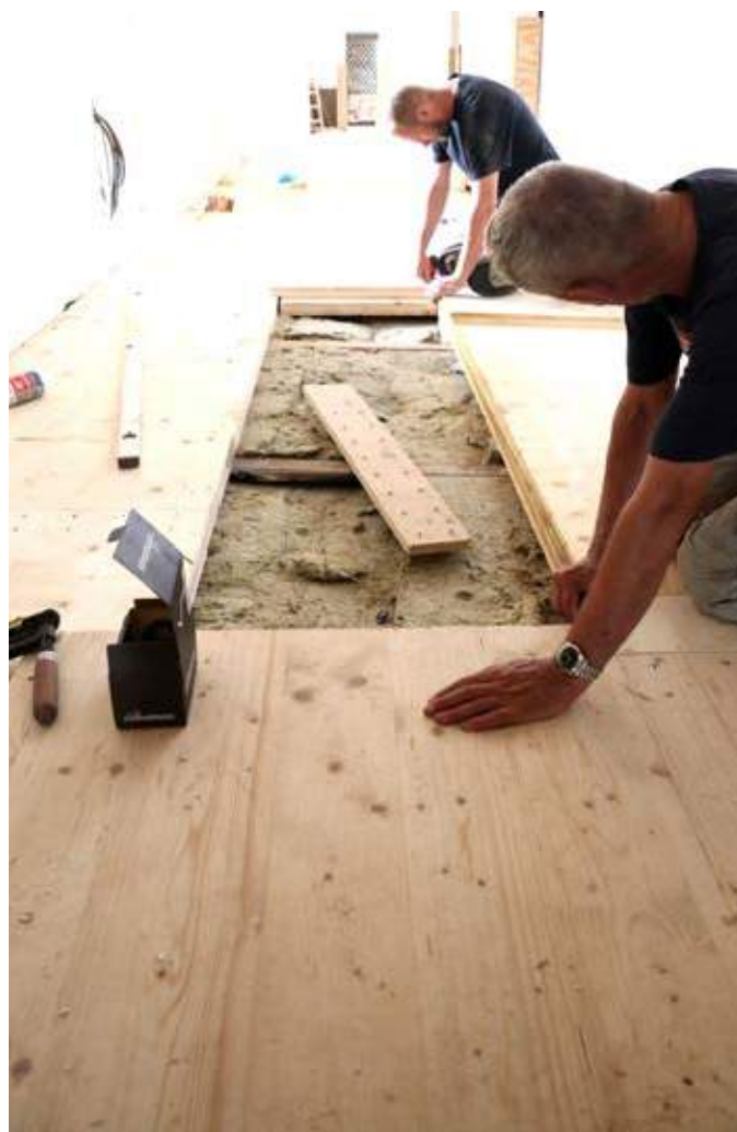
CLT elementer gør at gulvene i Nyborg Slot kan lægges med stor nøjagtighed.
