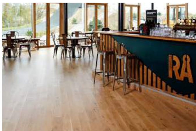
Gulvplanker på 15 mm af eg, her fra Amager Bakke forbrændingsanlæg og skibakke.
