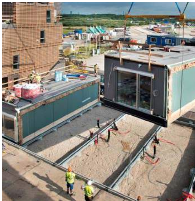
Det meste af modulet kan produceres i en industrihal og monteres i ét stykke på byggepladsen. Det forkorter byggetiden væsentligt.
