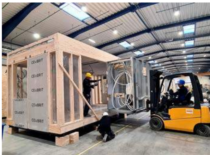
En tilbygning til Hotel Stop'n Sleep i Rødbyhavn er ved at blive bygget hos ABC Pavilloner i Engesvang i Midtjylland. Her ankommer badeværelset.
