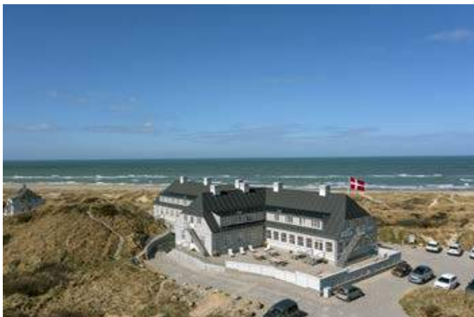
Svinkløv Badehotel er genopført i træ, men på et fundament og kælder i beton.
