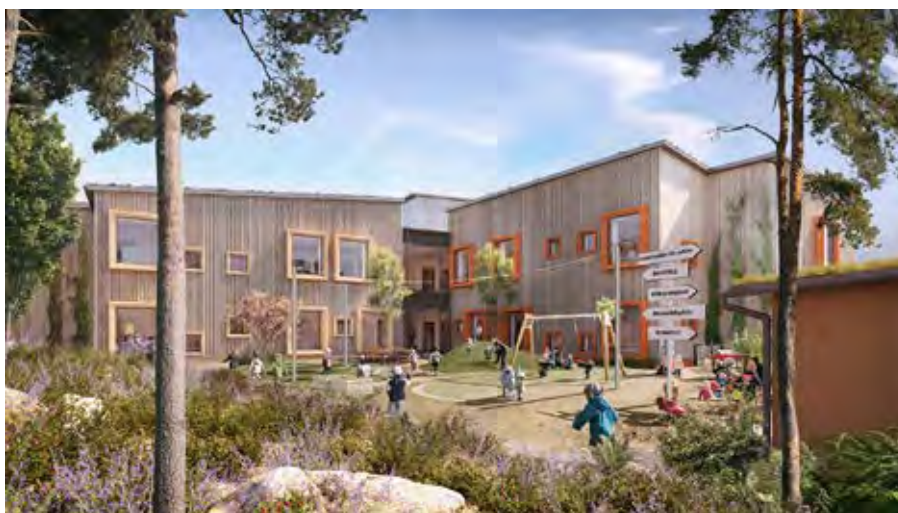
Skolen Hoppet i Göteborg har 70% lavere klimapåvirkning end en anden, tilsvarende skole. Det skyldes bl.a. anvendelse af krydslamineret træ i den bærende konstruktion.
