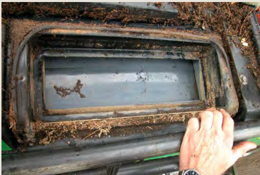
Foto 3. Filterboksen skal sikre, at al luft renses gennem filteret. Hvis der er snavs i kanalen bag filteret, så slutter filteret ikke tæt til filterboksen.
