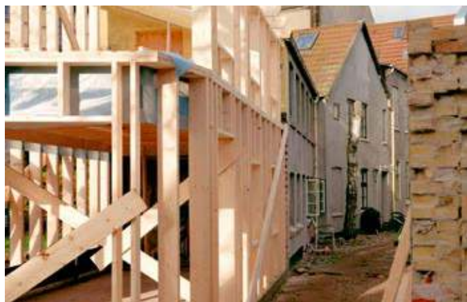
En tilbygning på 50 m 2 i to etager rejst på to dage med robotters hjælp.
