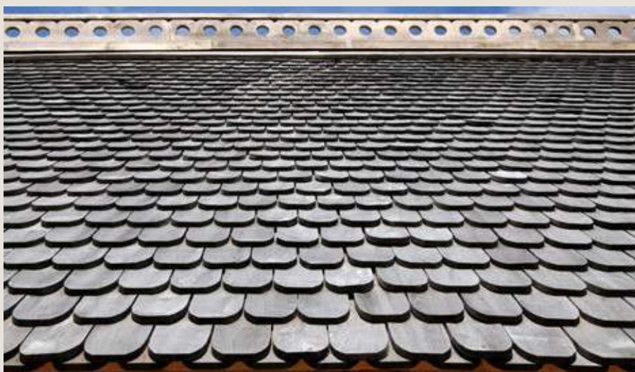
Der er monteret 24.000 tagspån på 1 meters længde af det fineste egetræ på de to huse.
