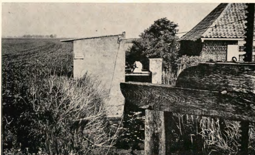
Ældre bestående pumpestation, som pumpeagregat bruges en snegl (Archimedes skrue).
