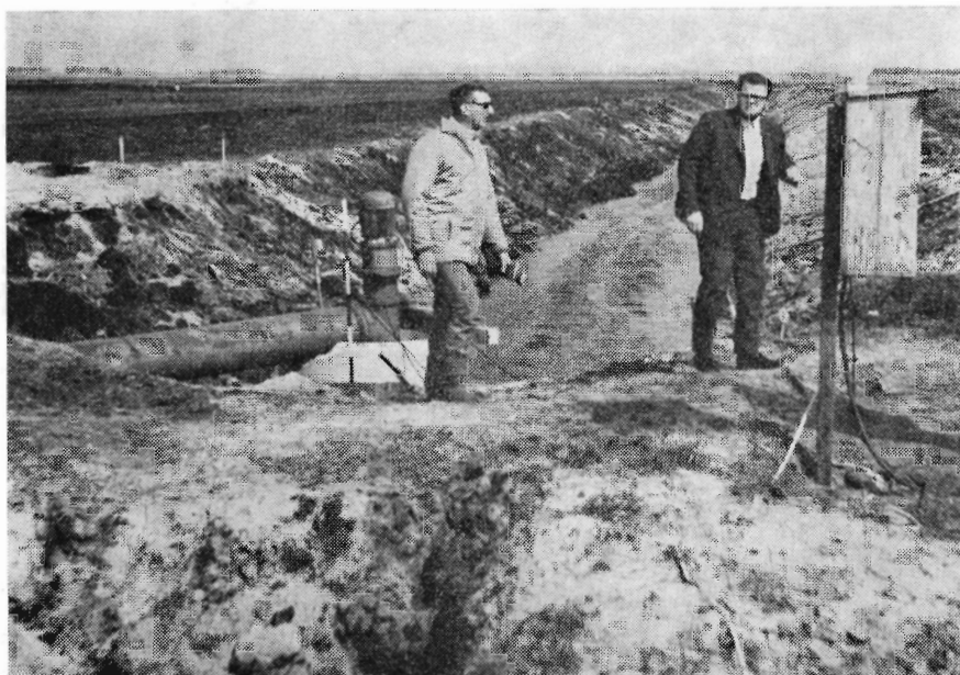
Ballum-Skast enge. – En midlertidig pumpestation er opført. Ved hjælp af denne skal blandt andet de vandmængder bestemmes, som den endelige pumpestation skal kunne klare. Der kommer meget vand fra den let gennemtrængelige undergrund.
