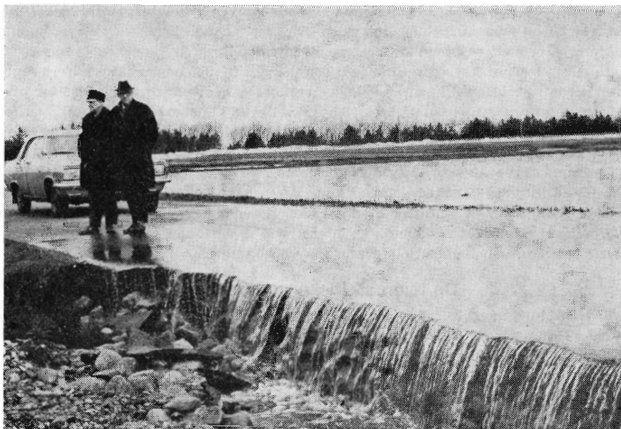
Tøbruddet den 18. marts 1970 ramte også Skjernå-arbejdet og forårsagede oversvømmelser på mindre arealer, men anrettede her kun ringe skader. Værst medtaget blev vejen over ådalen ved Gjaldbæk. Direktør Fr. Heick og afdelingschef N. Venov betragter her ødelæggelserne, medens oversvømmelsen fandt sted.
