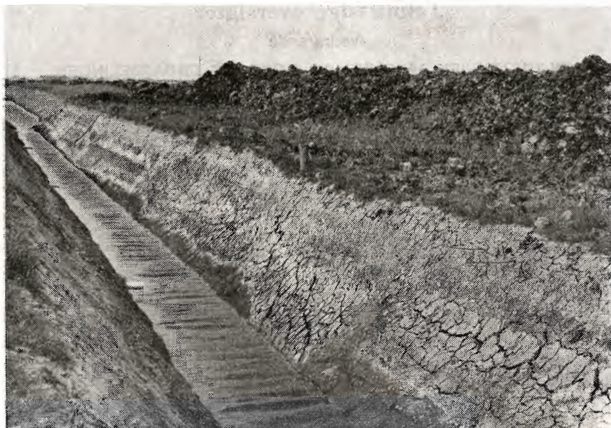
Ny afvandingskanal for dræningsforsøget i Holmbo kær. I billedets venstre side ses drænudløbene.
