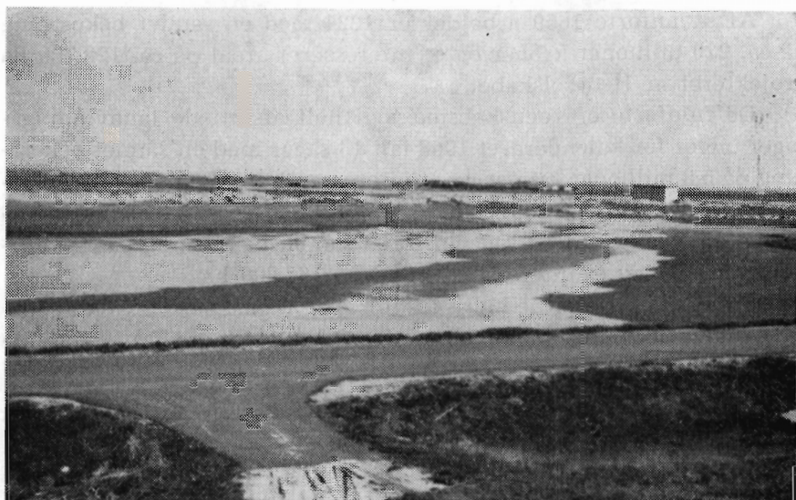
Udsigt over Bøvling fjord. Pumpestationen for Ramme å's opland, der er opført i hvide Synopalsten, skimtes i baggrunden.
