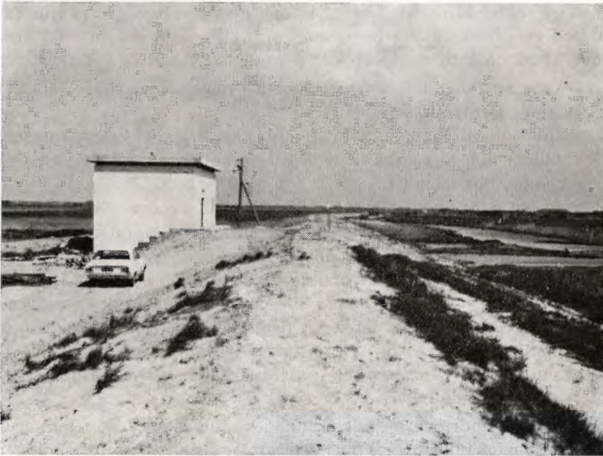
Pumpestationen for Ramme å. I stationen er installeret 3 pumper, hver med en ydeevne på 1750 l/sek.
