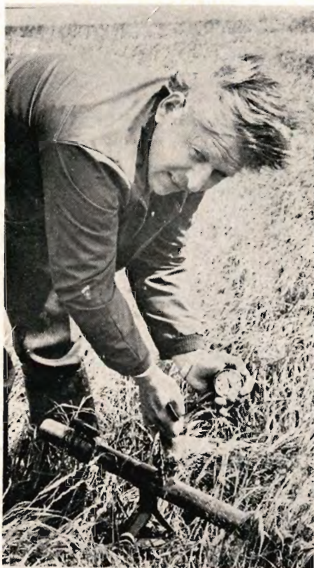
Dysetryk ved sprinkler kontrolleres med manometer.
