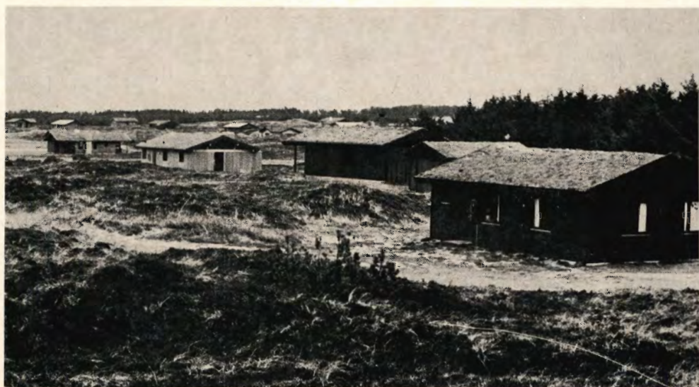
I sommerhusområdet Bredbjerg nord for Hune stod de lave partier under vand en stor del af året. Efter en afvanding med grundvandssænkning på 1½ meter er området ideelt til rekreativ benyttelse, og kun enkelte brøndlåg antyder grundforbedringen, som er udført af Hedeselskabet.
