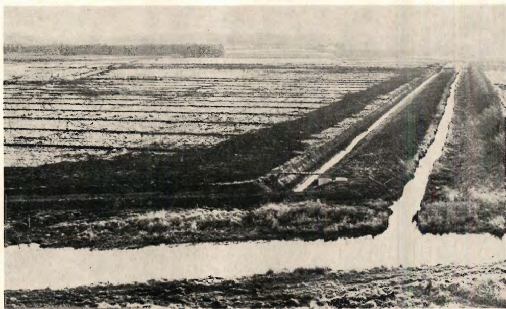
Drænet areal ved Løvskaal. I forgrunden Nørreåen og til højre pumpebrønd ved pumpekanal og skelgrøft.
