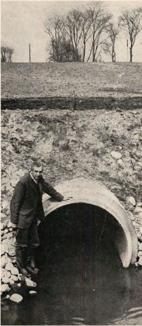
N. Jespersen ved Grønåens udløb gennem den 150 cm rørledning, som på bakken bagved er lagt ned i 8 meters dybde.
