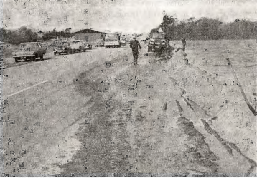
Fra hovedvej 11 den 19. marts 1970 kl. 12 middag. Vejvæsenet er ved at opbygge en sandvold langs vejkannten mod øst for at hindre, at oversvømmelsesvandet fra området går over den stærkt trafikerede landevej. (fot. has.)
