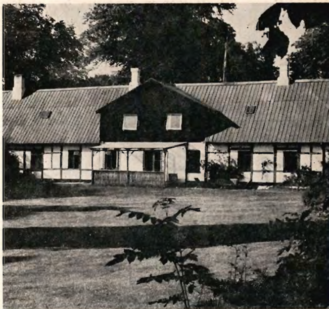
Hedeselskabets gamle skovriderbolig Hjedsbækgård i Himmerland umiddelbart før nedrivning.
