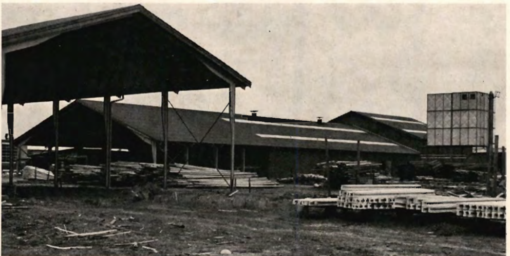
Nye bygninger hos Hedeselskabets Træindustri i Brande. Forrest et hjørne af lagerhallen og i baggrunden produktionshallen.
