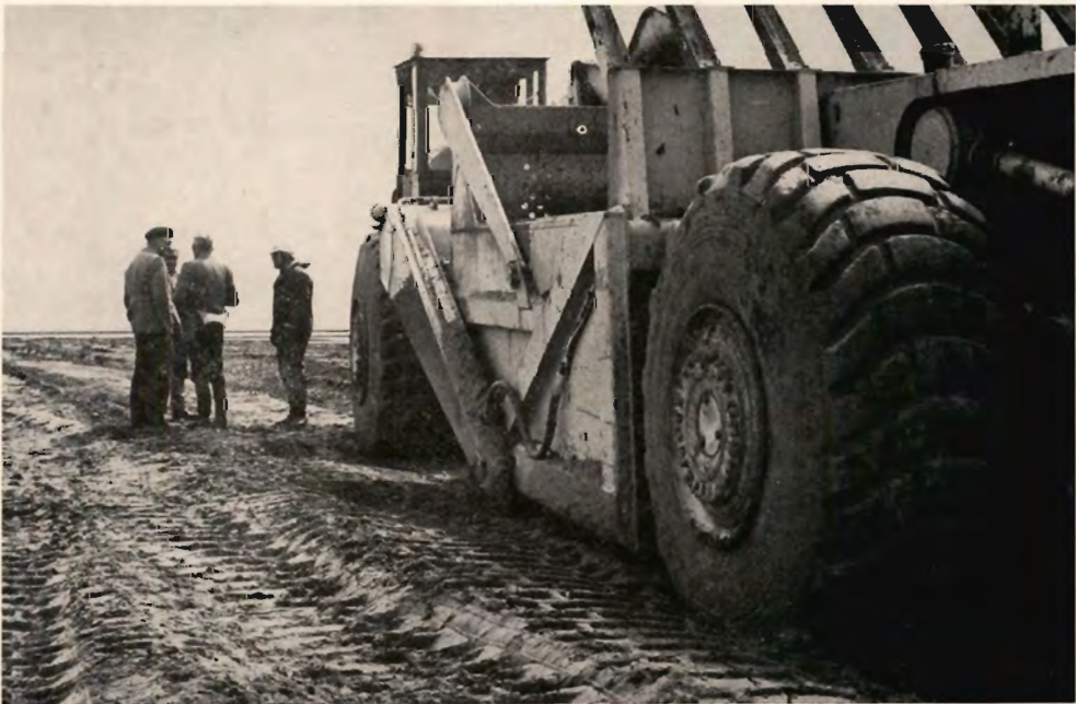
Hedeselskabets Maskincentral har i samarbejde med entreprenør Søren Pedersen, Brande, retableret 13,8 km af Rejsby-diget efter stormflodskatastrofen i 1976.
