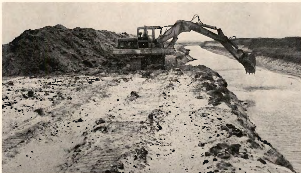
Vestre landkanal i Fiil Sø forlægges på en strækning af 1400 meter.
