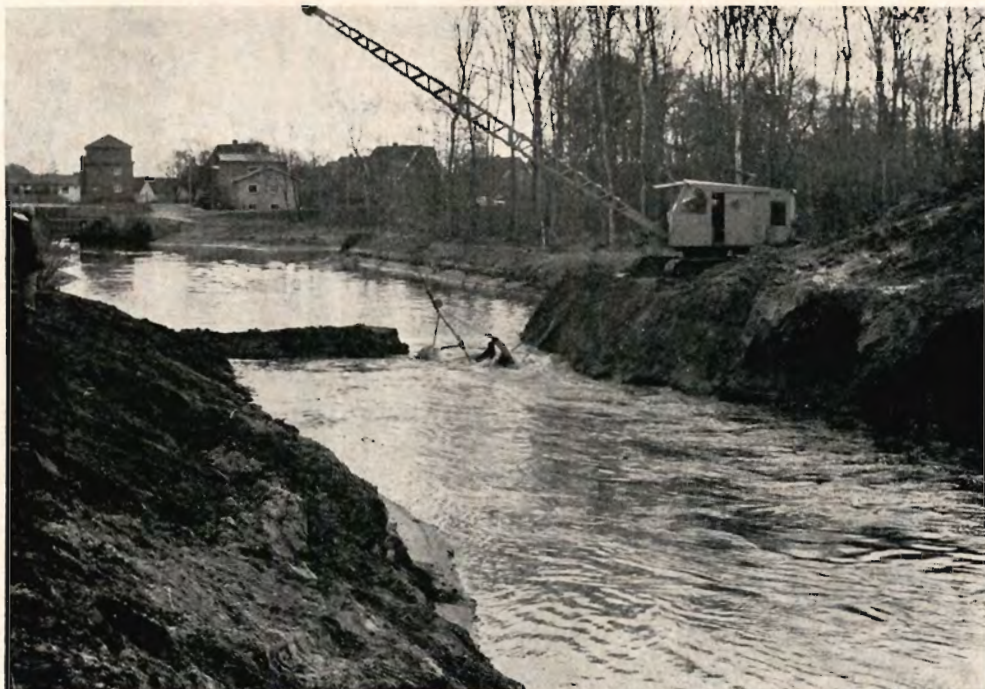
Gennemgravning til Storåens nye leje ved Poul Andersens tømmerhandel i Holstebro. Ved at skære en åslyng væk forkortes åløbet med 300 meter.
