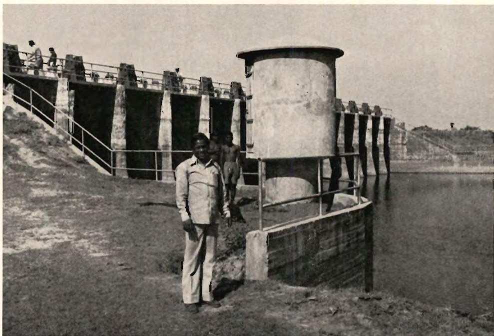
Sluse i den sydlige del af Bangladesh. Det overvejes at bygge en pumpestation ved siden af slusen for at kunne overrisle nogle tusinde hektarer bag slusen i tørtiden.
