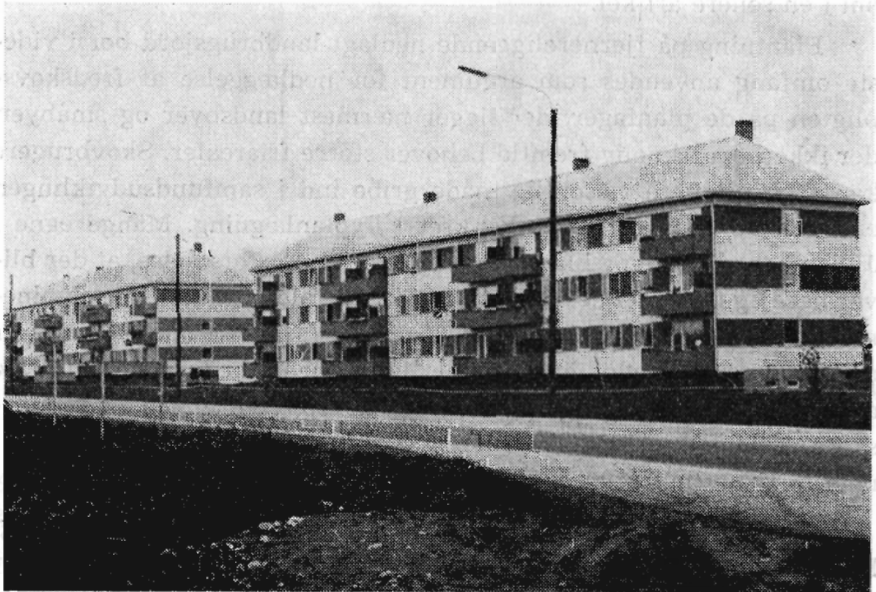
Fig. 1. Nogle af de 3-etagers boligkarréer, der er opført på 2-3 meter dyb høj- mose i Heimdalsmyren syd for Trondheim.
