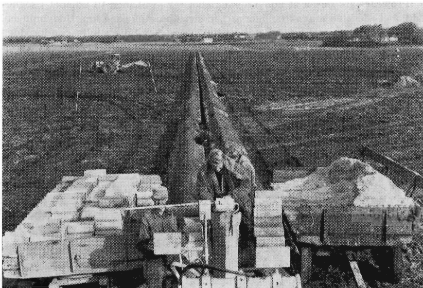
Hedeselskabets specialdrængravemaskine transporterer selv vognene med lerrør og savsmuld til filterpakning af rørledningen. Under gode forhold ligger præstationen mellem 1500 og 2000 meter nedlagt drænledning pr. dag.
