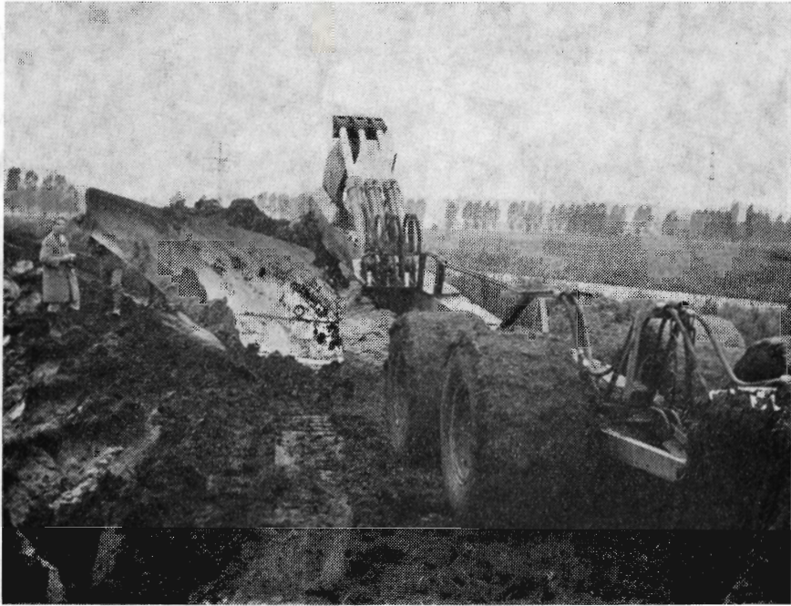
Fig. 1. Dybdepløv. Pløjedybde: 120 cm. Nødvendig trækraft: 350 hk.
