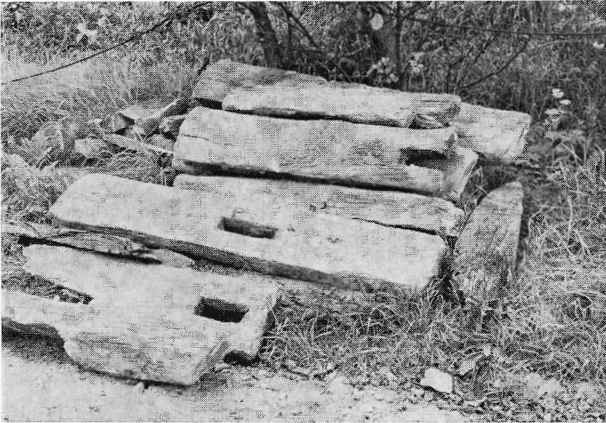
Under udgravningen ved restaureringen af Povlsbro fandt Nationalmuseets folk en del bøgetømmer, der har været brugt som underlag for stenbroens enkelte pæle. Tømmeret menes at være dele af bindingsværk fra en bygning, altså nedlagt i 1844, da den nuværende bro blev opført (fot. has, aug. 70).
