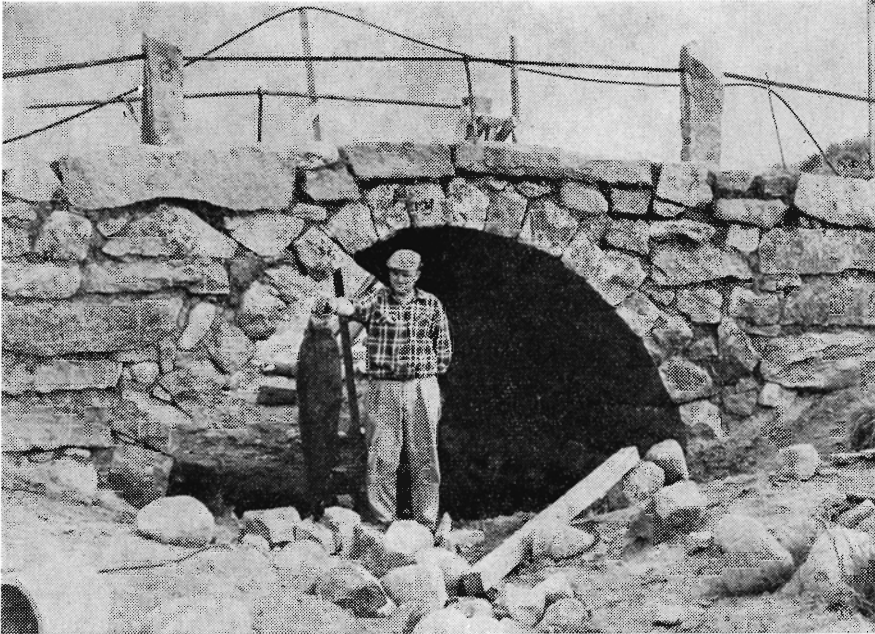
Arbejdet med Povlsbro er her næsten afsluttet. Broen er understøttet og rettet op, nedfaldne sten er sat på plads, og ingen steder vil det være synligt, at der er indstøbt en masse cement. På billedet ses en af arbejderne stående i åløbet lige før vandet igen føres i åen. Han står med en af de svære egepæle, der blev fundet i flere rækker parallel med åen som rester af en ældre pælebro. (fot. has., aug. 70).
