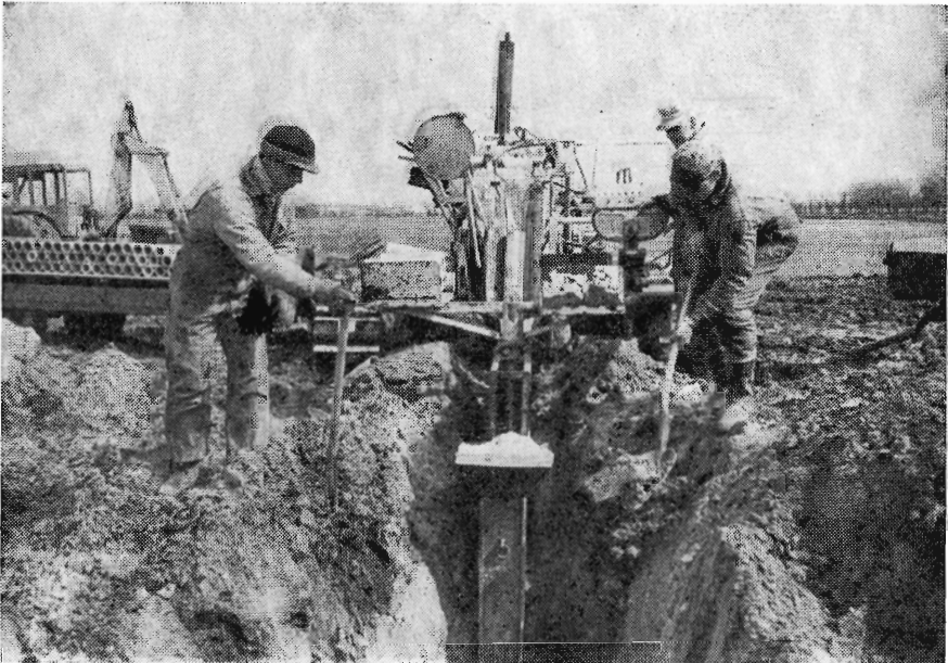
Pakning af lerrørsledning med savsmuld. Gennem en tragt føres savsmuldet ned over ledningen i den ønskede lagtykkelse.
