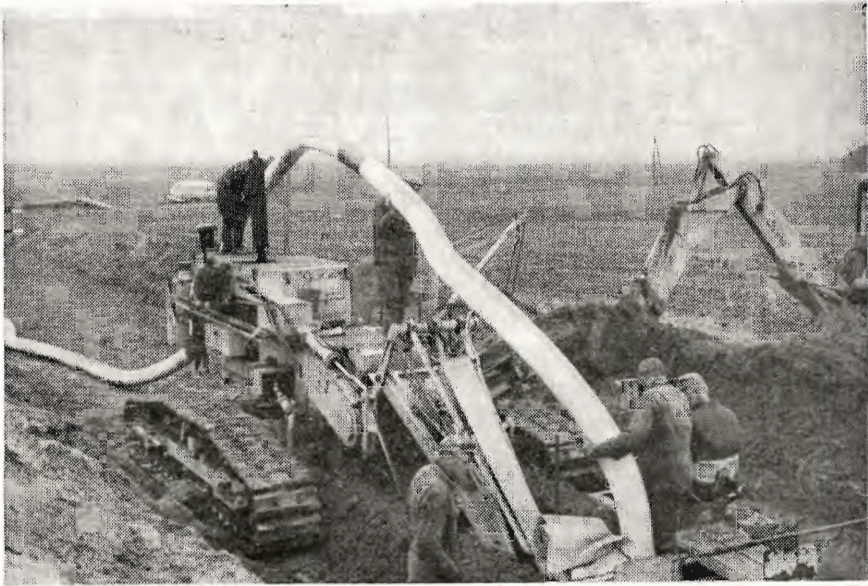
220 m plastrør nedlægges i 2 meters dybde på et flydesandsareal i Vestjylland.
