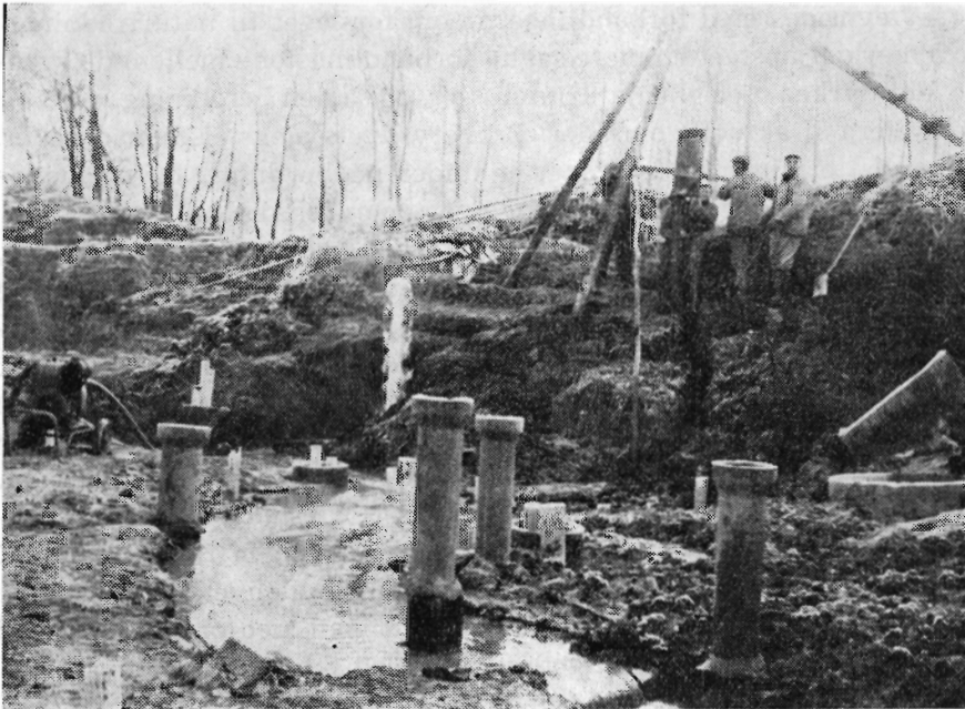
Begge billeder hentet fra en trykvandsdræning ved Borrevejle i forbindelse med vejanlæg. Øverst aftedes gennem det lige etablerede ca. 12 meter dybe lodrette dræn ca. 10 liter vand pr. sekund.
