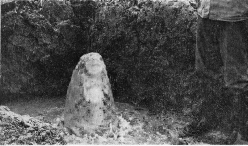
Begge billeder hentet fra en trykvandsdræning ved Borrevejle i forbindelse med vejanlæg. Øverst aftedes gennem det lige etablerede ca. 12 meter dybe lodrette dræn ca. 10 liter vand pr. sekund.
