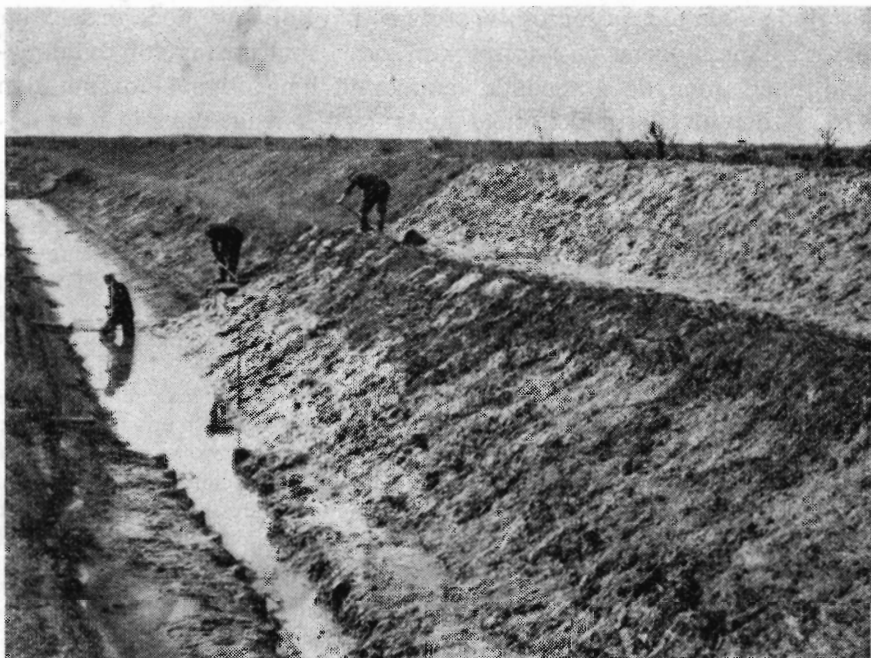
Oprensning af pumpekanalen i Ribe Holme-forsøget.
