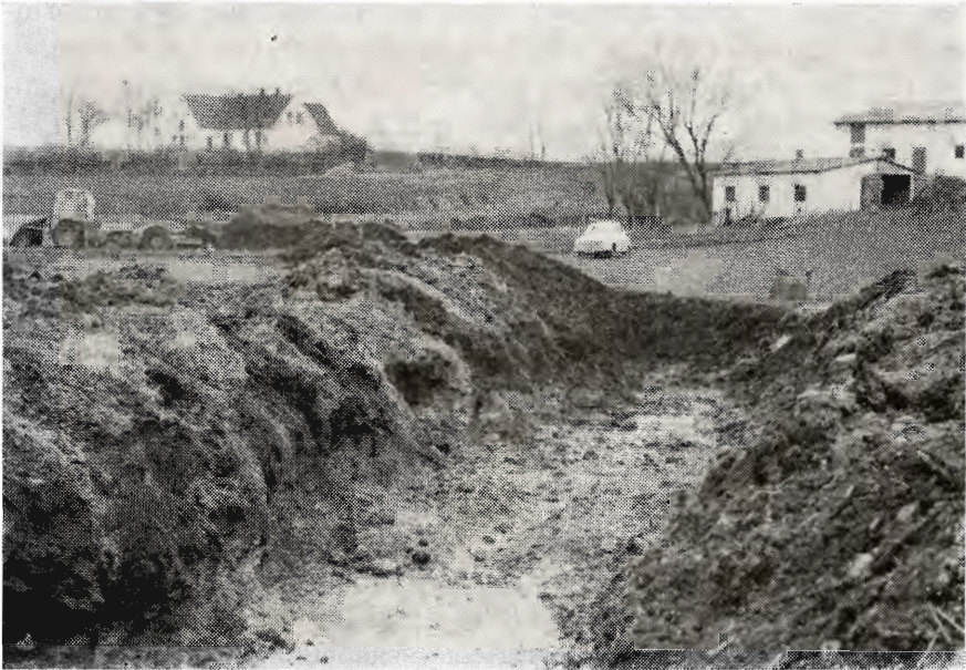
Et »blødt« sted, hvor det er svært at arbejde med det tunge maskineri under grundforbedringsarbejdets udførelse.
