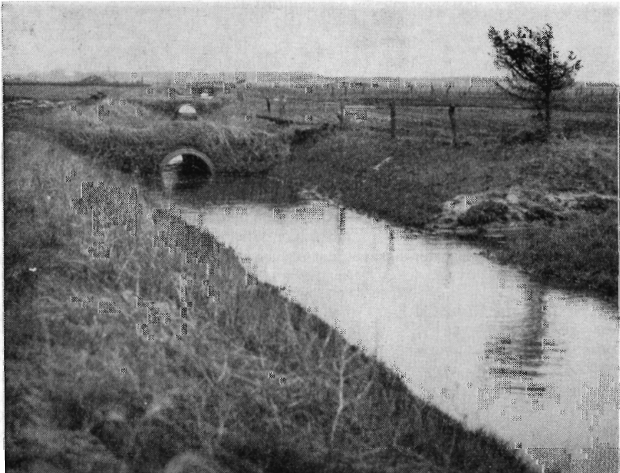
Tre brøndstyrt i Langengbæk ved Gram — afløbet for Kastrup-Tiset enge.
