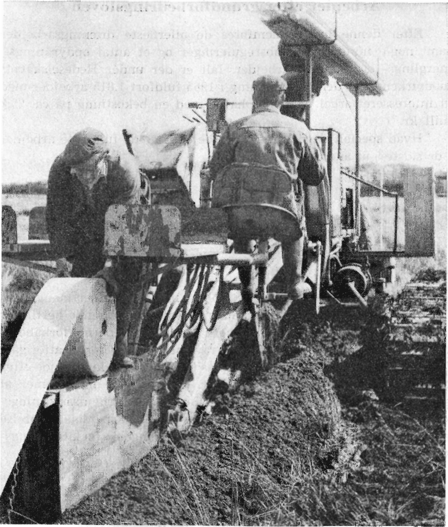
Maskindrøning med plastrør og rørdækning med glasfilt.
