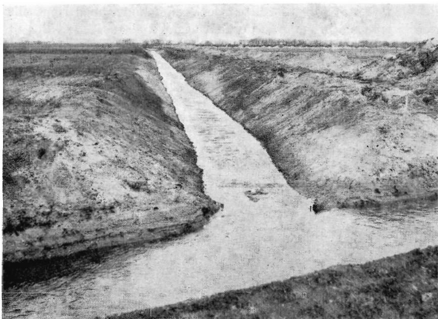
Kanalarbejde i landvindingssag i Stenderup enge i Sønderjylland.
