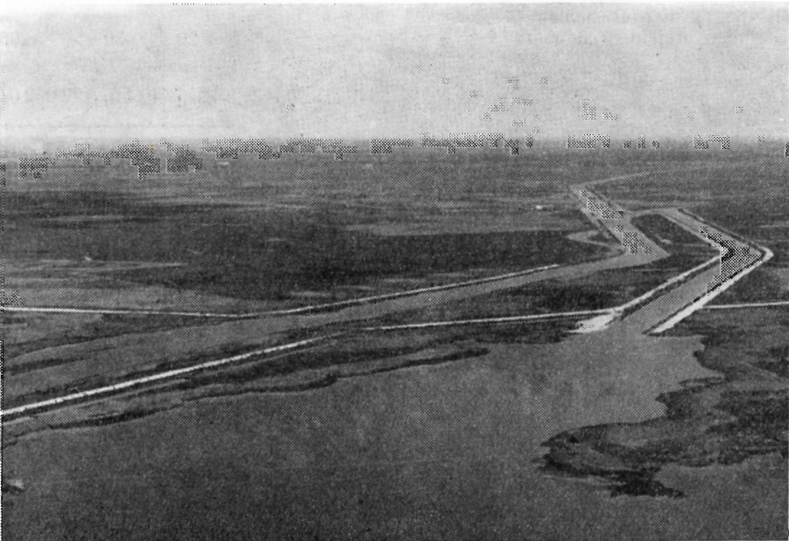
Set mod øst fra Ringkøbing fjord ind over engene. Vandløbet til venstre er den nye Skjernå, der har samme udløb som hidtil. Til højre for ses den nye sydlige parallelkanals udløb.
