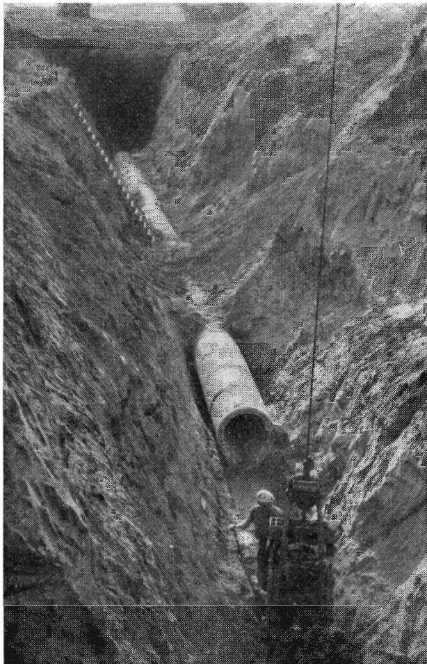
Dybtliggende aftøbsledning i Hammelev.
