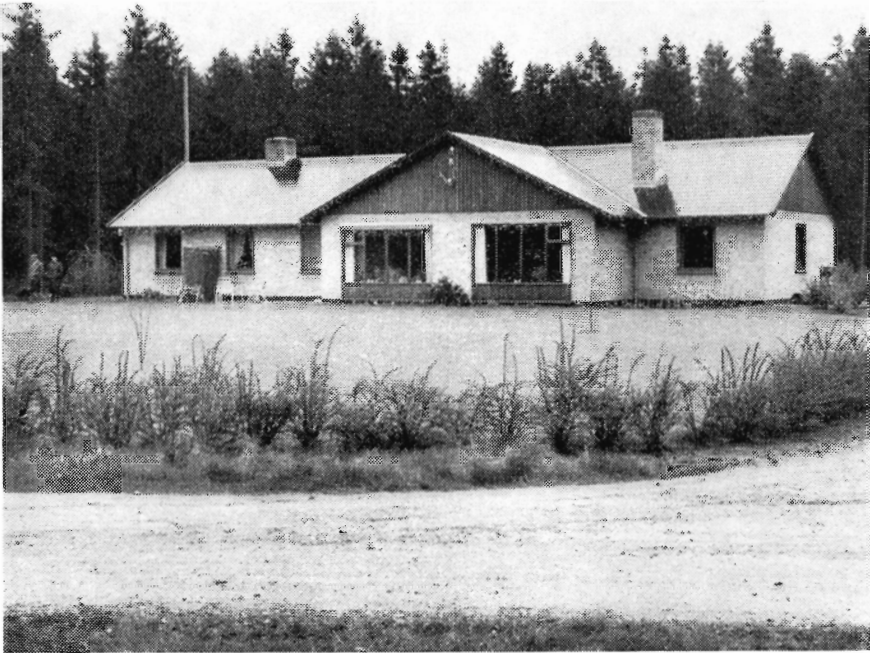
Skovriderboligen i Grindsted plantage, opført 1961.
