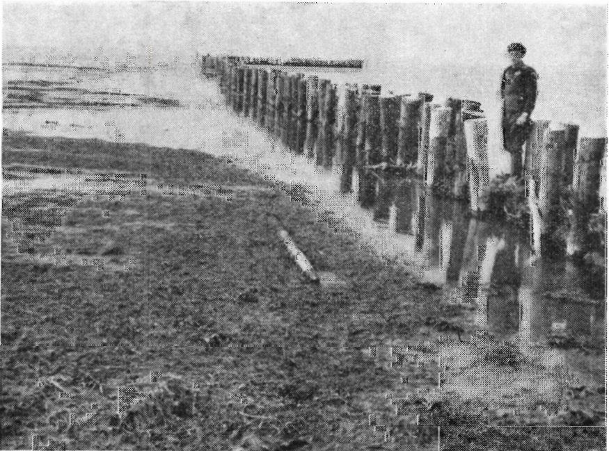
Faskindæmning til begrænsning af indpumpet dynd ved Egholm.
