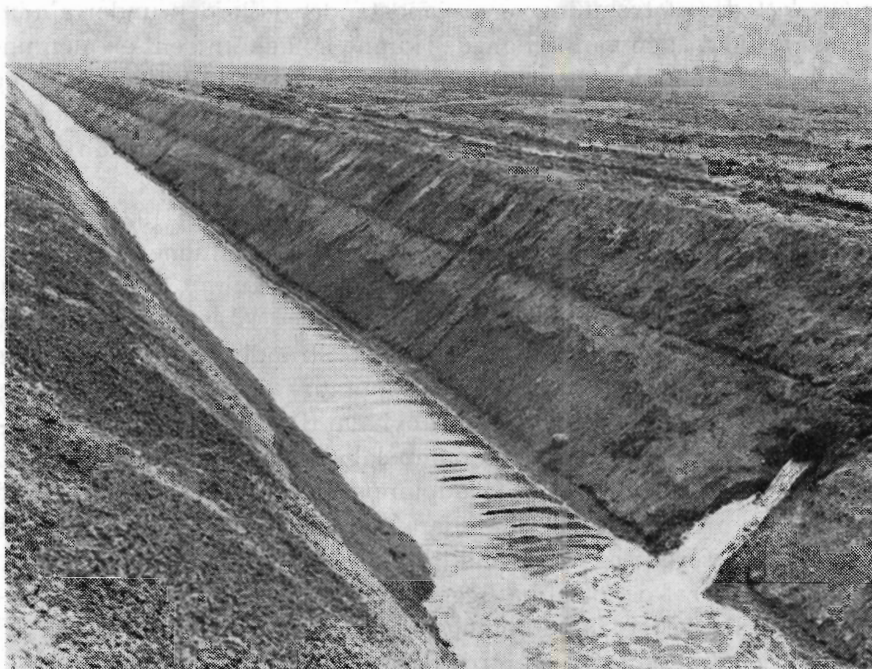
En afvandingskanal, der i 1967 er uddybet med ca. 1,25 m. Rørledningen med udstømning fra en mindre sidekanal viser nogenlunde uddybningen. Fot. has.
