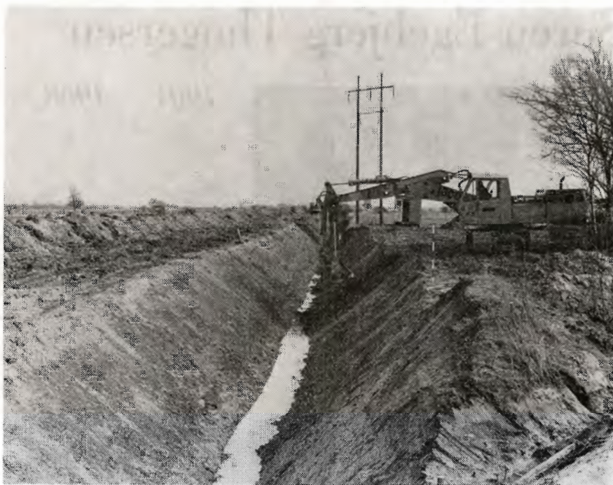
Overalt i Rødby fjord arbejdes der stadig med uddybning af kanalerne, men hele projektet ventes først bragt til endelig afslutning i 1969. Fot. has.
