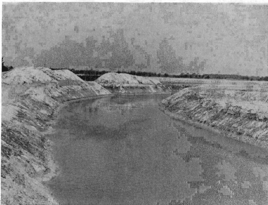
Den store samlekanal, der fører afstrømningen fra 20.000 ha til pumperne. Billedet er taget ca. 200 meter fra pumpehuset. Materialet fra kanalens uddybning er endnu ikke udplaneret. Kanalen fører også afløbet fra Rødby's kloaksystem til havet. Fot. has.
