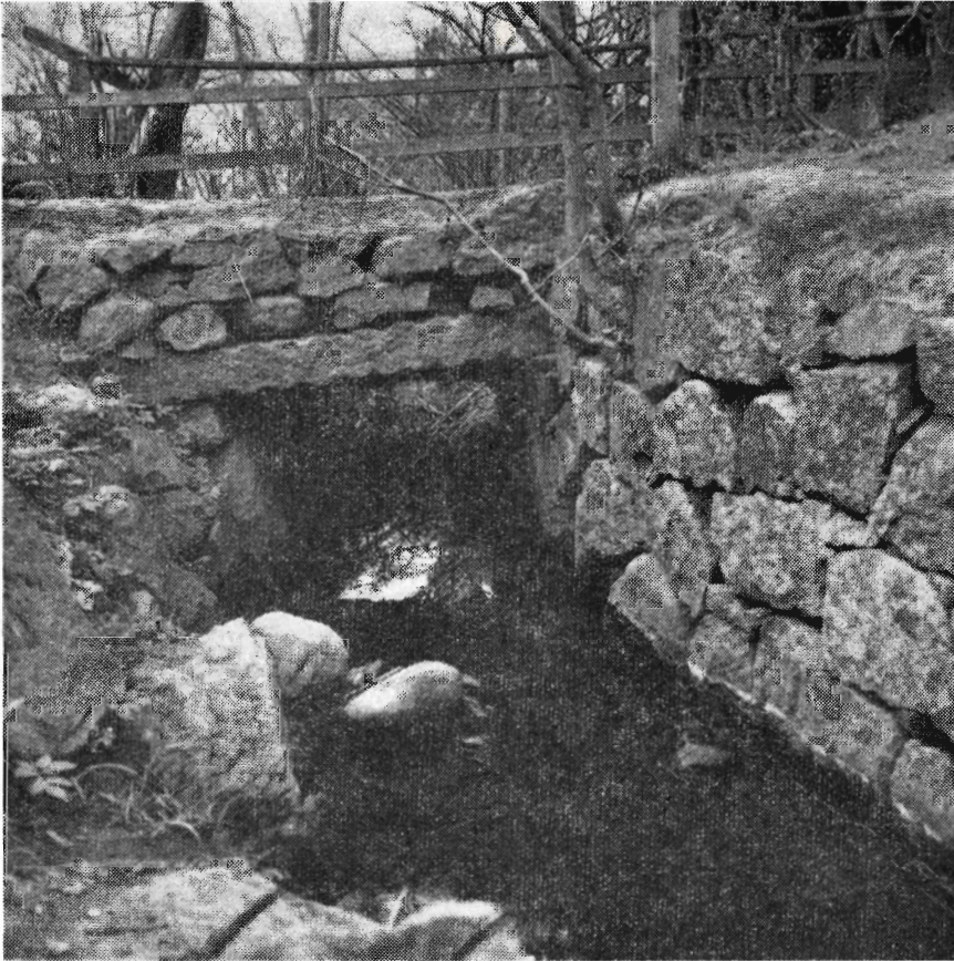
Gammel stenboks under vej på Falster. Den er nu afløst af rørledning.
