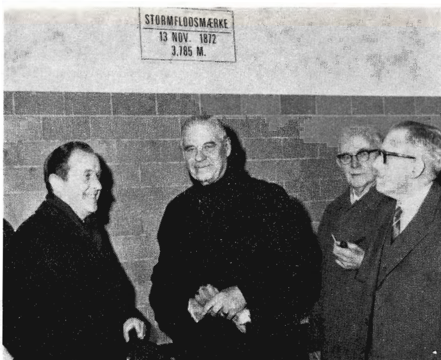
Den 19. december 1967 toges den nye pumpestation ved Marrebæk i brug. Foran højvandsmærket fra 1872, der er opsat i det nye pumpehus, er fotograferet en del af gæsterne. Fra venstre: sognerådsformand P. H. Mathiasen, amtsrådsmedlem, kmh. J. C. V. V. Grandjean, Vennerslund, digelagets forretningsfører Th. Rasmussen og dets formand H. Corneliussen. Højvandsmærket, der markerer 3,785 over daglig vande, giver et indtryk af, hvor højt vandmasserne har stået i 1872.
