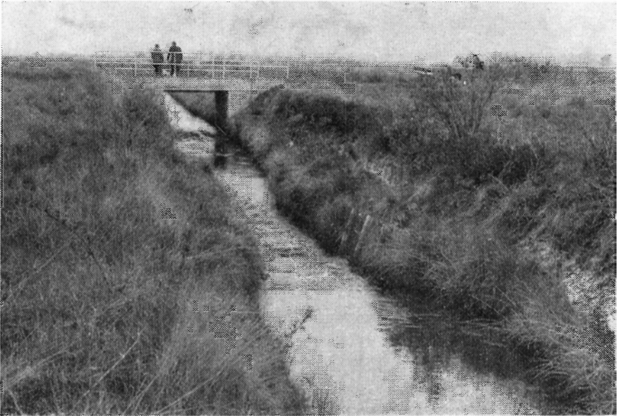
Den nye Simmel afvandingskanal. I forgrunden ses et af de større styrt og bagved en af de nye, elementbyggede broer.
