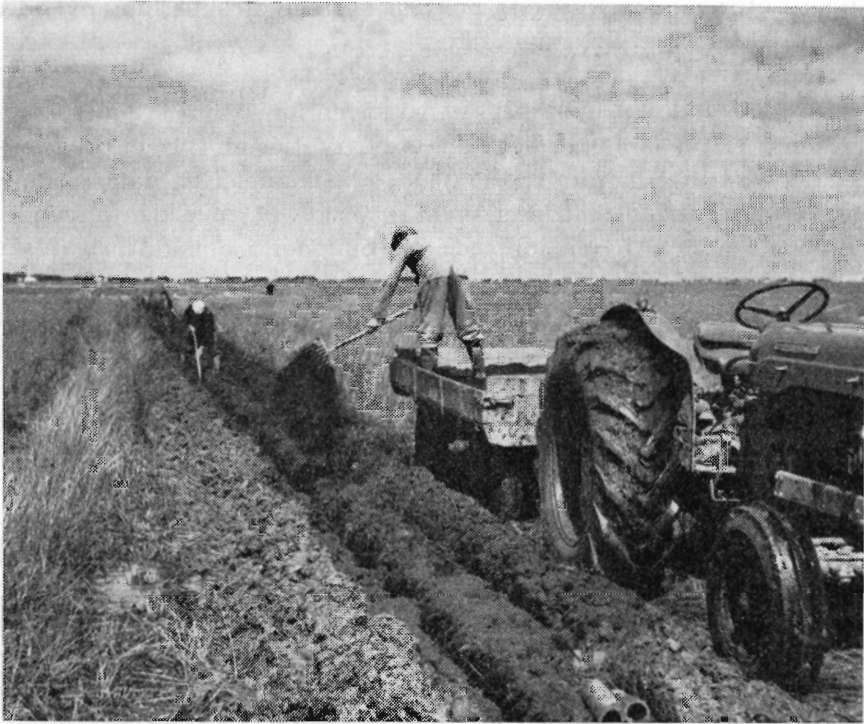
Drænledningen dækkes med tørvestrøelse for at forbedre tilstrømningen og hindre indtrængning af sand.
