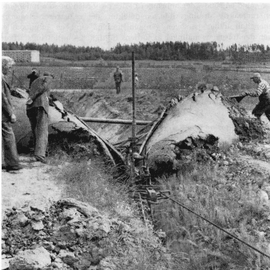
Meget svær finsk grøfteplow, der trækkes af et dobbeltspil.
