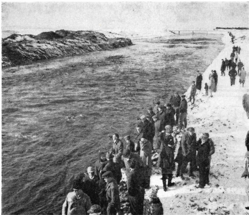
Et lille kvarter efter at vandet var ledet ind i det nye 45 meter brede leje strømmede vandet ud mod fjorden. I baggrunden skimtes en af de nye broer.
