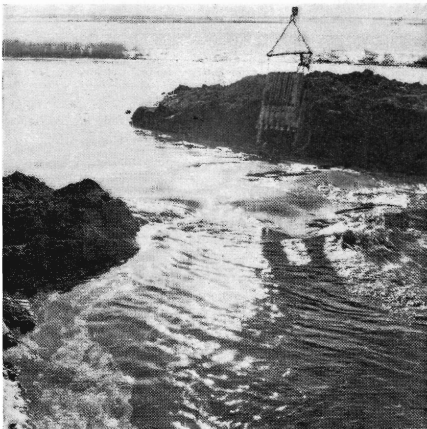
Gravemaskinen har fjernet den sidste jordvold, og vandet vælter ind i det nye åleje.
