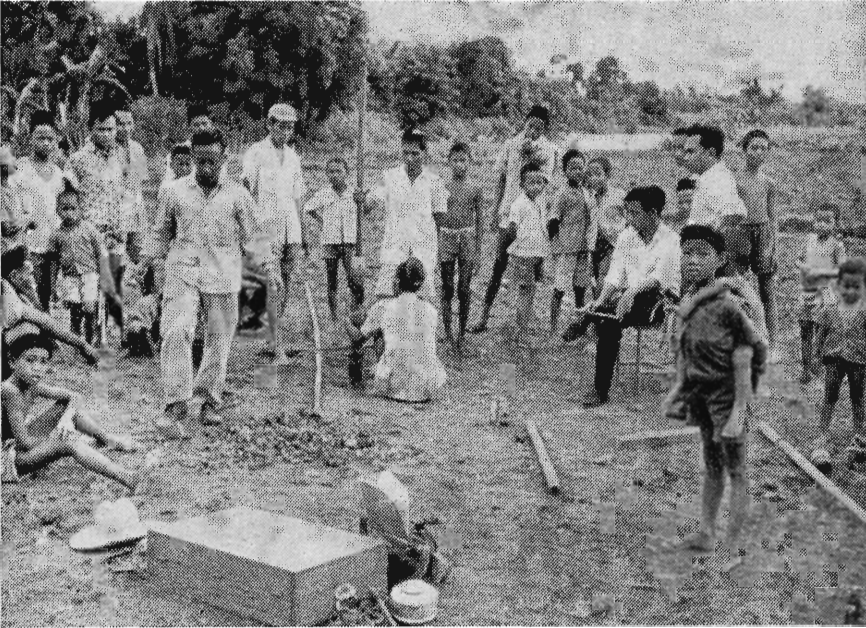
Boreholdet fra Bandung i færd med vingeboringer. Til højre på stolen og umiddelbart bag denne ses de to indonesiske arkitekter, der havde været i København i to år og stadig arbejdede med projektet.
