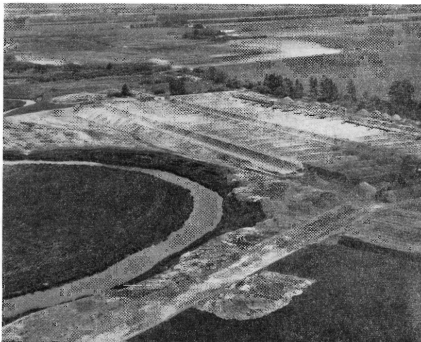
Dambrug under udførelse i forbindelse med større vandløb.
