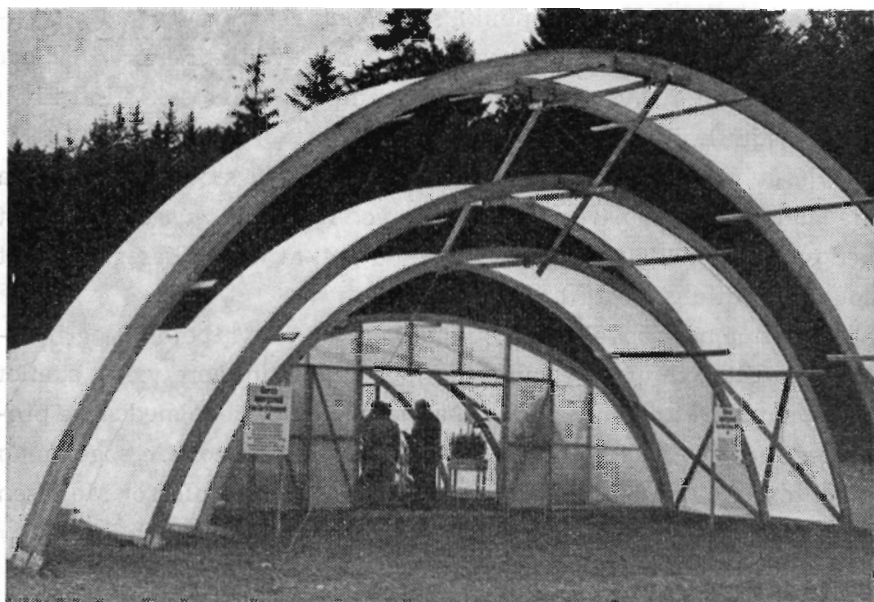
På udstillingen vistest varianter af Usko-huset, en lamelbygning med plastic-overtræk. Huset har fundet særlig anvendelse til hurtig fremdrivning af planteskoleprodukter.
