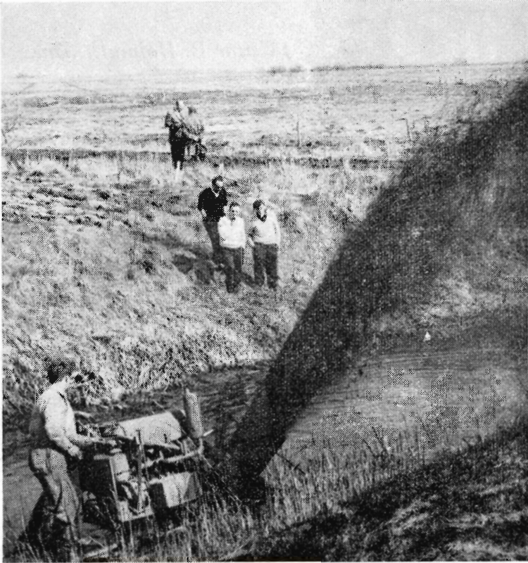
En større model af et grøfterenser-aggregat i arbejde i en landkanal langs diget mellem Højer og Rudbøl.
