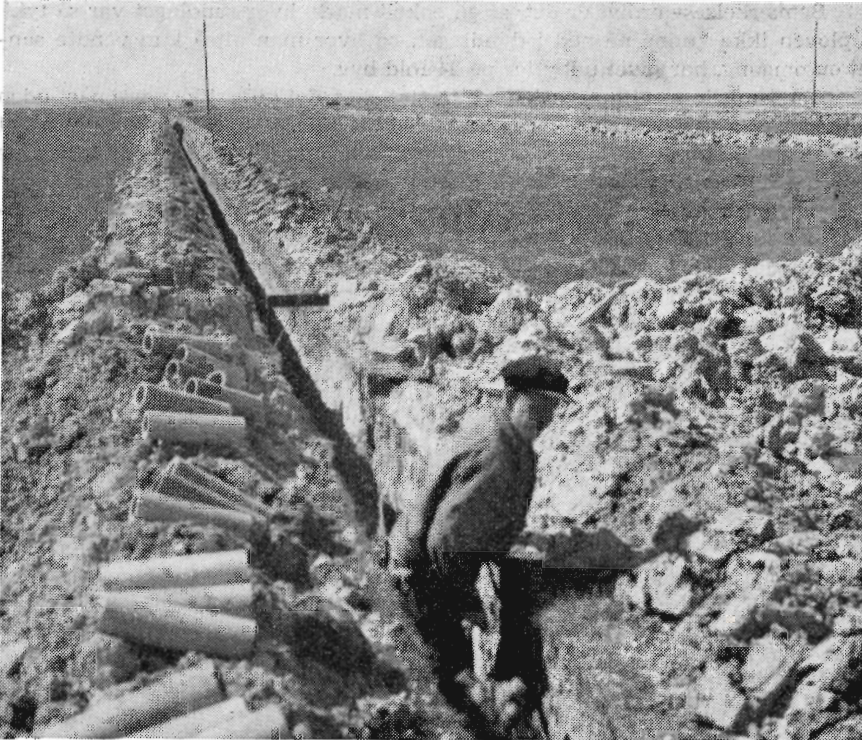
Det var endnu i 1961 overalt teglrør, der blev brugt ved dræningen på Gyl-densten.
