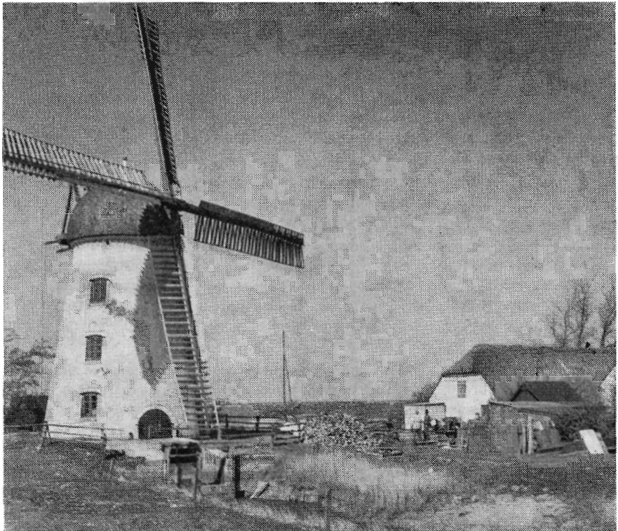
Den gamle vandmølle varetog i mange år udpumpningen af afstrømningen fra strandengene og oplandet omkring Gyldensten.
