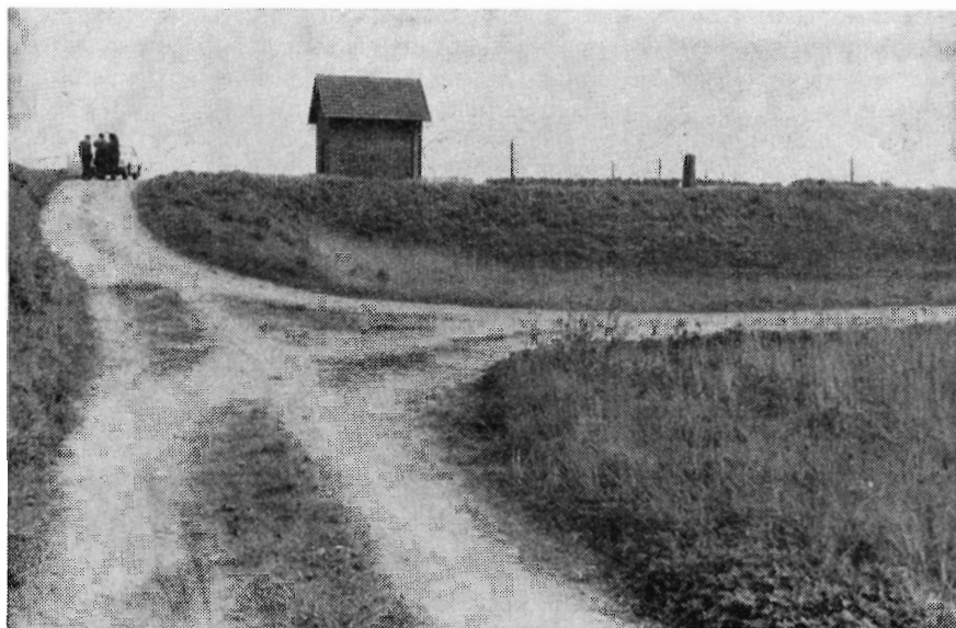
Vejføringen omkring pumpehuset ved Gyldensten's Inddæmning. Vejen til højre fører ind i land, medens vejen midt i billedet går langs diget mod havet. Fot. 1968
