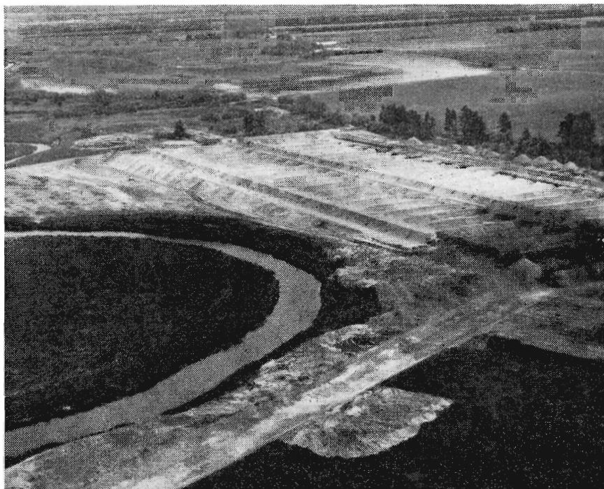
Som omtalt i beretningen er Hesselvig Enggaard borforpagtet. På den del af engene, der her ses, er den nye forpagter ved at indrette et større dambrug. I forgrunden ses Skjernå. Fot. H. S.
