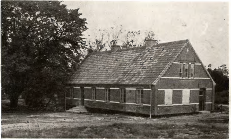
Den gamle Hovedbygning paa Borup Vandmølle, fot. Skodshøj, der nu er Forstanderbolig for den Ungdomslejr, der udfører Tilplantningen af de sammenkøbte Arealer.
