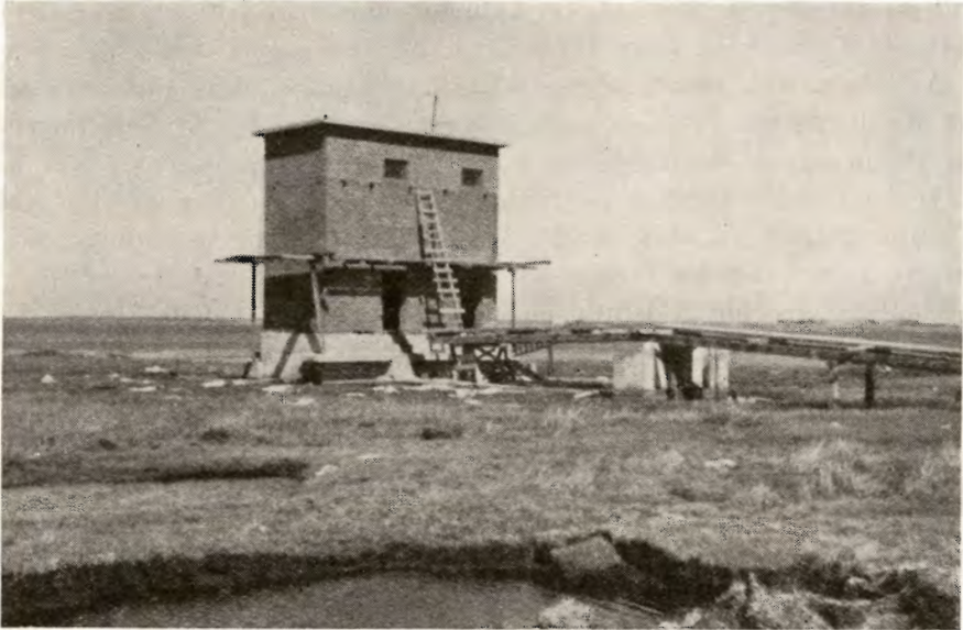
Et Pumpehus bygges ved de nye Afvandingsarbejder fot Skodshøj. ved Sydenden af Fiilsø.
