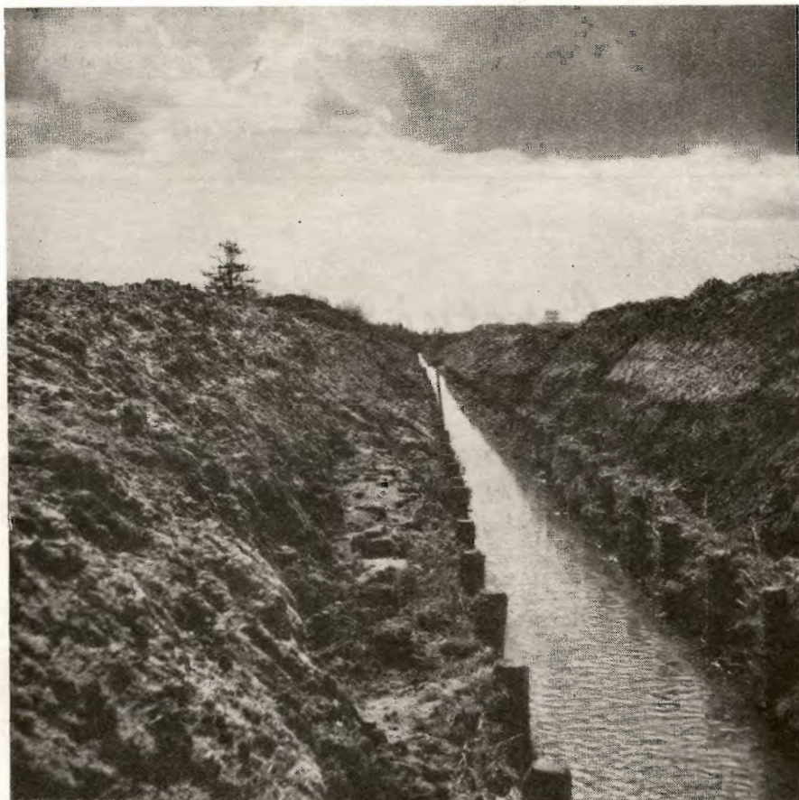
Afløbsgrøft med Sikring med Pæle og Faskiner af Vandløb fot. Skodshøj. i Frijsendal Enge.
