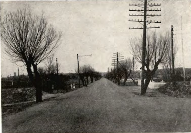
Fig. 6. Viborg Landevej inden Vejens Udvidelse og Forhøjelse blev gennemført. I Forgrunden til højre og til venstre for Vejen ser man Diget, i Højde med hvilket Vejen nu er hævet, saaledes at der med passende jævn Overgang er frembragt en Pukkel paa Vejen. Nu er Træerne fjernede og Vejen udvidet med brede Fortove, saa den fremtræder som en moderne Gade.
