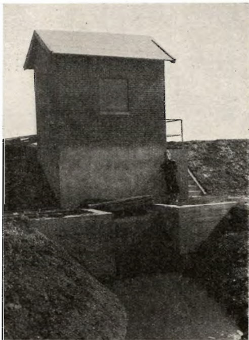
Fig. 2. Pumpehuset set fra Indløbssiden. Terrænet, hvor Drengen staar, ligger i Højde med Engoverfladen eller ca. 20 cm over Daglig Vande i Skive Havn. Vandspejlet i Afvandingskanalen er af Pumpen sænket til ca. 1,75 m under Terræn. Dikekronen ligger 1,9 m over Daglig Vande i Skive Havn.
